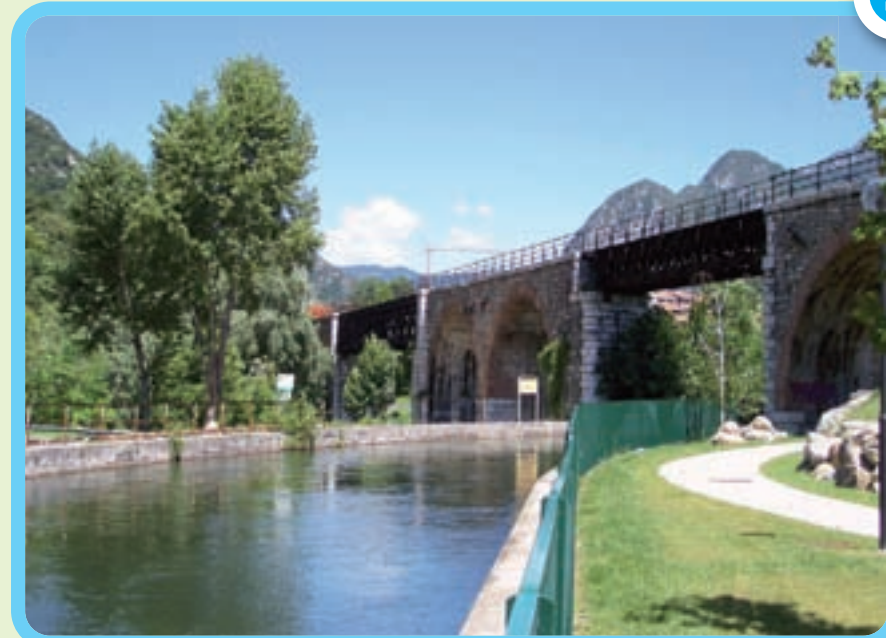
Il ponte a Pompegnino della ex ferrovia Rezzato-Vobarno
