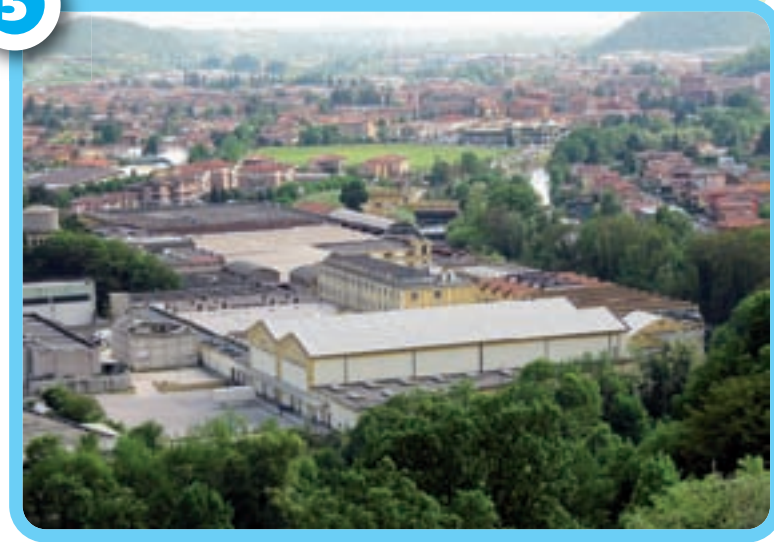
Il complesso dell'ex Lanificio di Gavardo oggi
